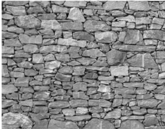
Bild NA.L.4 — Beispiel für Bruchstein-Schichtenmauerwerk
