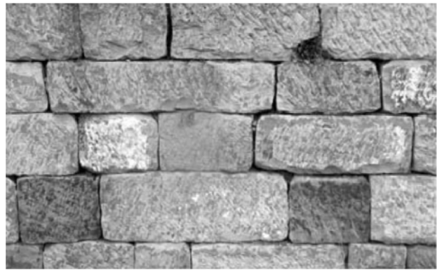
Bild NA.L.7 — Beispiel für Regelmäßiges Schichtenmauerwerk Güteklasse N3
