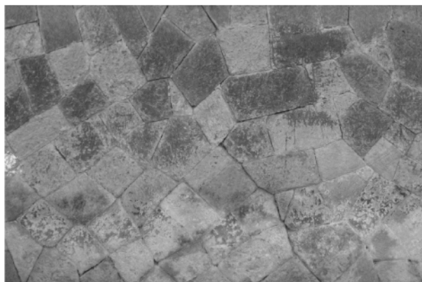
Bild NA.L.3 — Beispiel für Zyklopenmauerwerk
