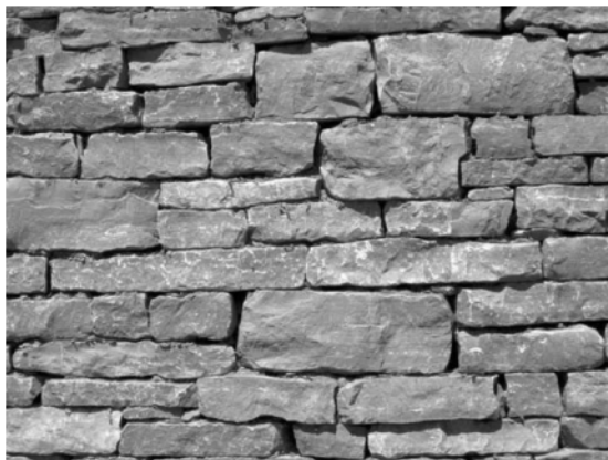
Bild NA.L.5 — Beispiel für Schichtenmauerwerk Güteklasse N2
