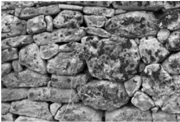
Bild NA.L.1 — Beispiel für Findlingsmauerwerk
