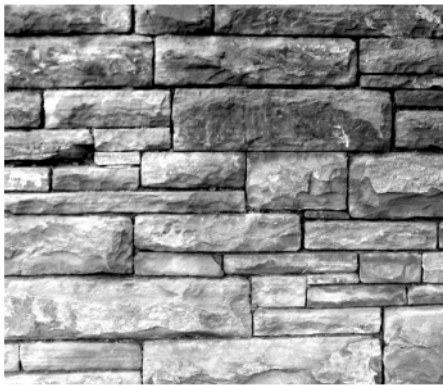
Bild NA.L.6 — Beispiel für Unregelmäßiges Schichtenmauerwerk Güteklasse N3
