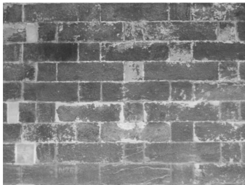
Bild NA.L.8 — Beispiel für Quadermauerwerk
