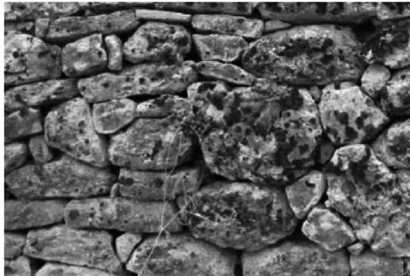
**Bild NA.L.13 — Beispiel für Findlingsmauerwerk**
