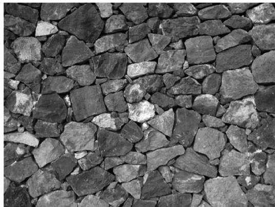
**Bild NA.L.14 — Beispiel für Bruchstein-Zyklopenmauerwerk**
