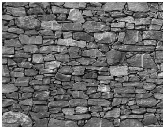
**Bild NA.L.16 — Beispiel für Bruchstein-Schichtenmauerwerk**
