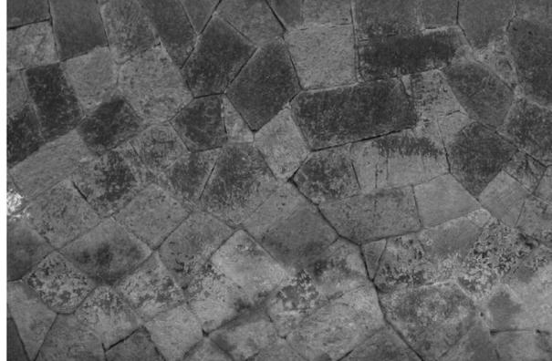
**Bild NA.L.15 — Beispiel für Zyklopenmauerwerk**
