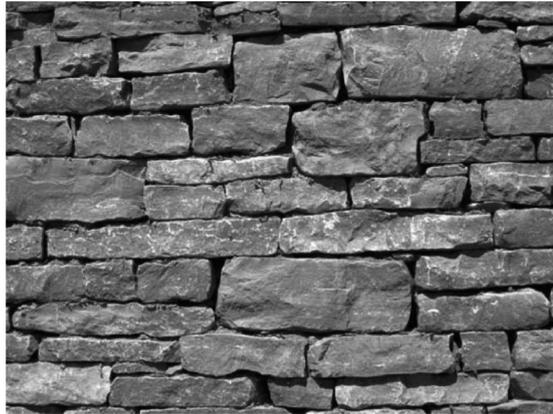
**Bild NA.L.17 — Beispiel für Schichtenmauerwerk Güteklasse N2**
