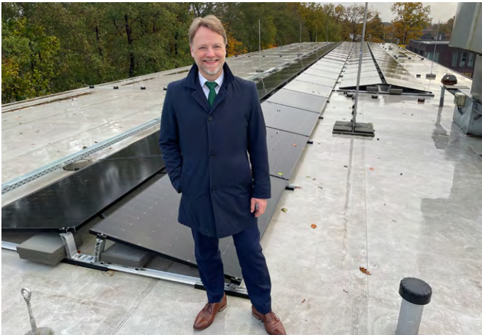
Finanzminister Gerald Heere vor der neuen Photovoltaik-Anlage auf dem Finanzamt Oldenburg.
